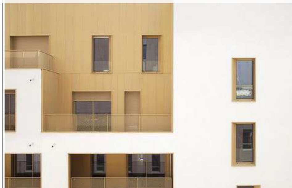
Delimitarea culorilor realizată la modificarea de planuri în câmpul aceleiași fațade - DA
